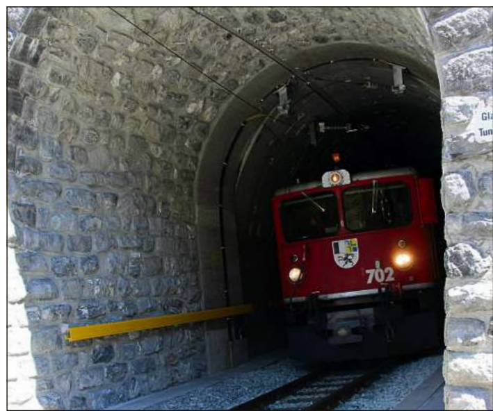
En ils proxims 50 onns vegnan sanads tut ils tunnels da la Viafier retica. Il tunnel Glatscheras è stà l'emprim.
